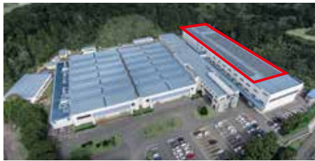
菊川工場の太陽光発電設備(赤枠)
