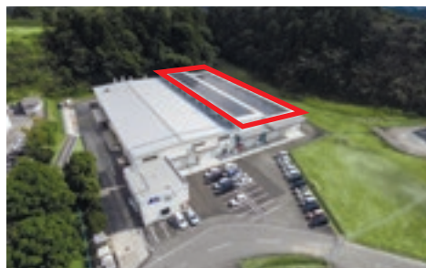
スターメタル(株)の太陽光発電設備(赤枠)
