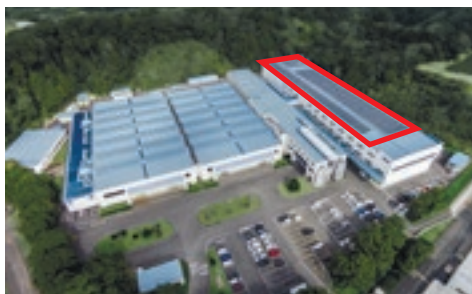
菊川工場の太陽光発電設備(赤枠)
