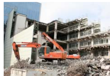
本社工場2号棟解体工事の様子
