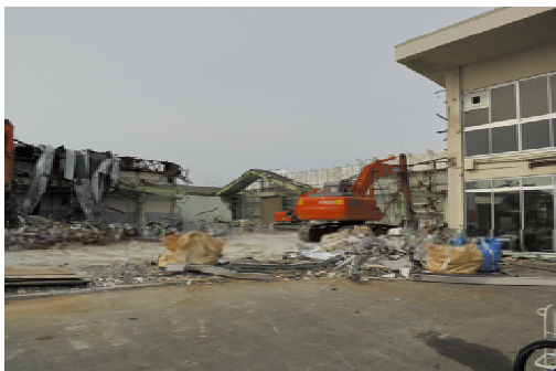
瀬名川工場 解体の様子
