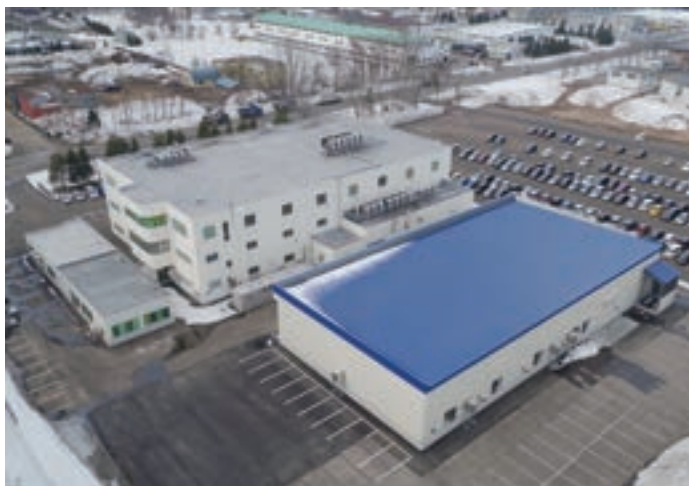
右下が今回増設した新工場棟
